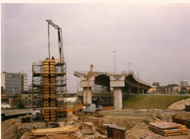
Bau der Hochstraße, Juni 1978
